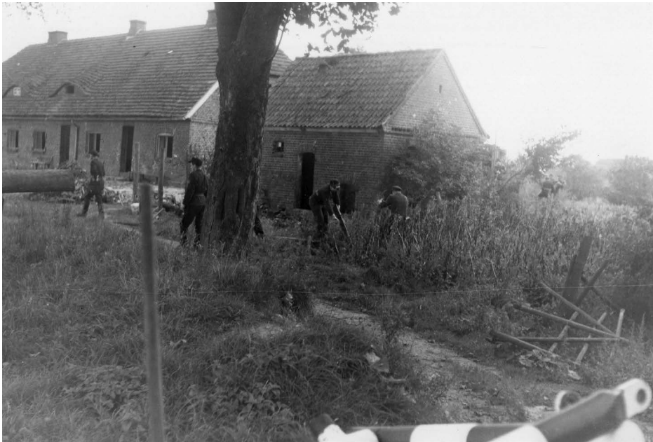
Aufnahme von der Verlegung der Abschrankung in Wietingsbek durch DDR-Grenzpolizisten.
