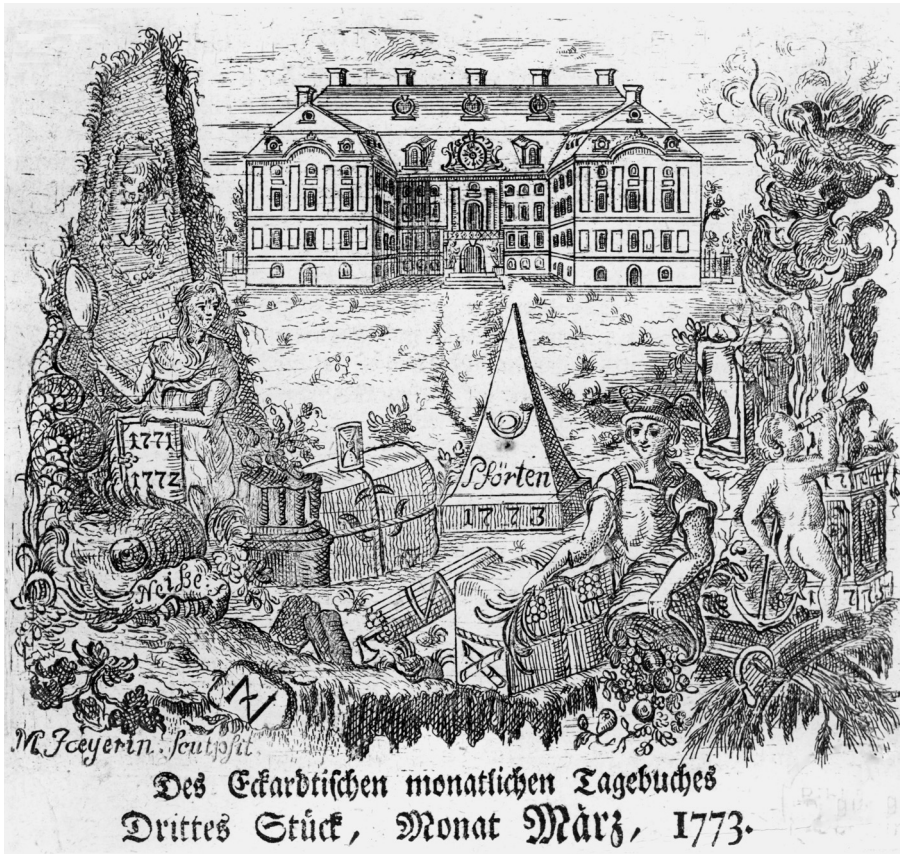
Pforten, Hoffassade des Schlosses, Kupferstich von 1773
