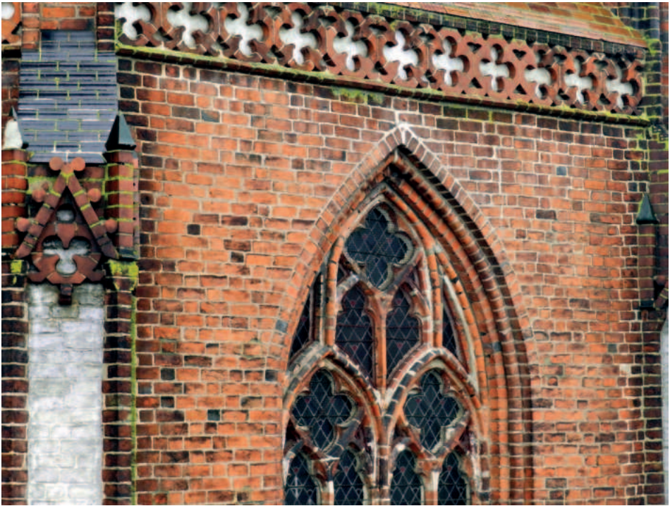
Prenzlau, Marienkirche. Teilweise mittelalterliches Fenstermaßwerk aus Backstein der Zeit um 1320 im Chorscheitelfenster (Foto: Verfasser).
