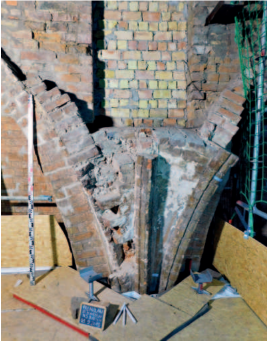
Prenzlau, Marienkirche, erhaltene mittelalterliche Rippenanfänge an der nördlichen Langhauswand zu Beginn der Wiederherstellung der Gewölbe (Foto: Verfasser).
