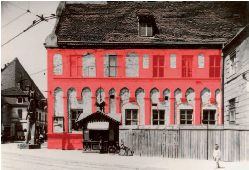
Brandenburg-Neustadt, Neustädtisches Rathaus nach teilweiser Putzabnahme ca. 1910. Rot eingetragen sind gotische Gliederungselemente und Fenster (Foto: Stadtarchiv Brandenburg an der Havel; Bearbeitung: Verfasser).
