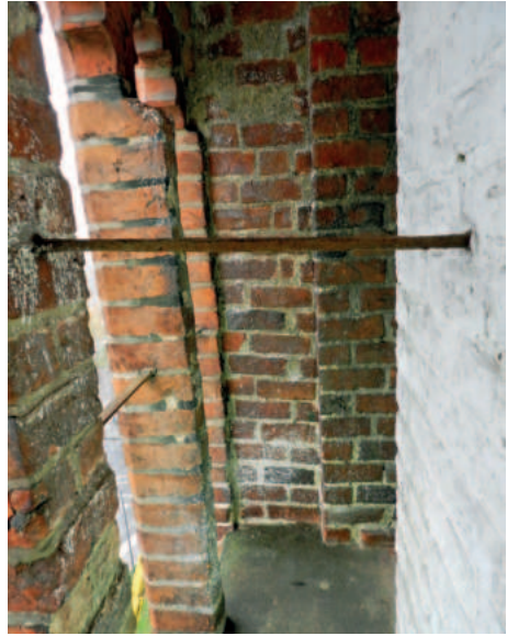
Prenzlau, Marienkirche. Bauzeitliche Eisenanker auf der Rückseite des mittleren Wimpergmaßwerks am Ostgiebel, um 1330 (Foto: Verfasser).
