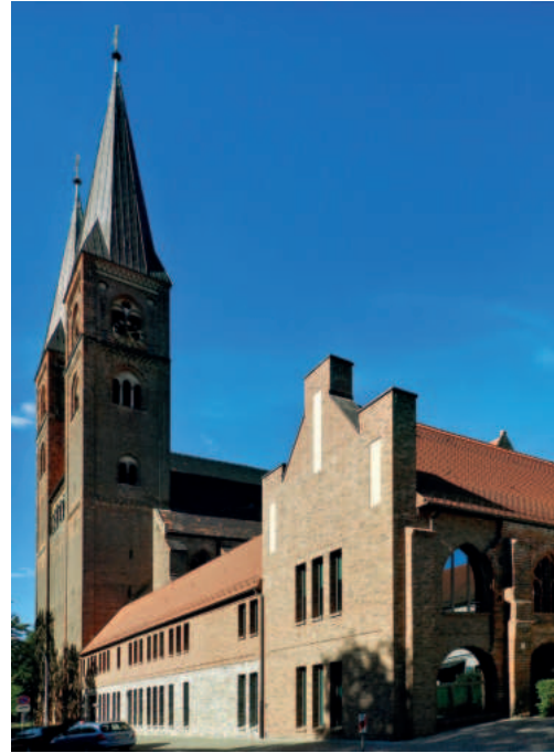
Stendal, Stiftskirche St. Nikolai. Westbau von Südwesten (Foto: Verfasser).
